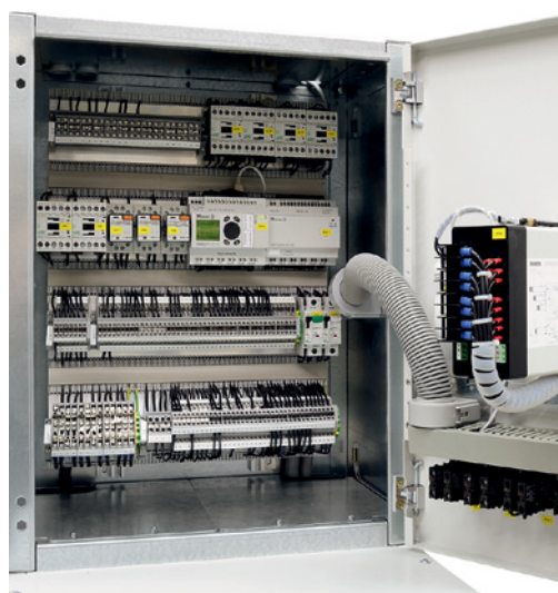
Реле easy800 можно устанавливать в шкафу управления, а также в распределительном щите.
