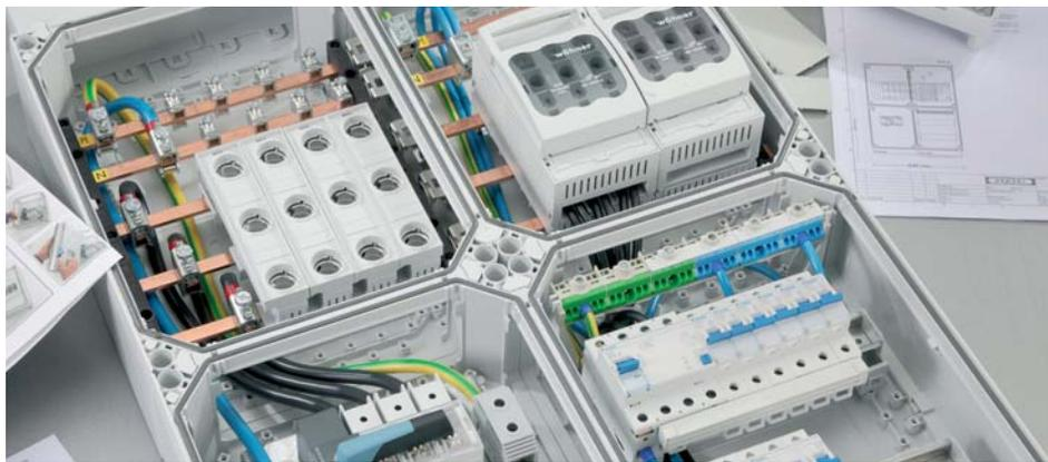
Подключение гибкой шины Mi VS ... с клеммой для прямого подключения к шине KS ...
