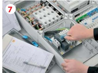
Необходимо проверить работу механических приводных устройств, надежность блокировок и замков, в том числе съемные детали.
