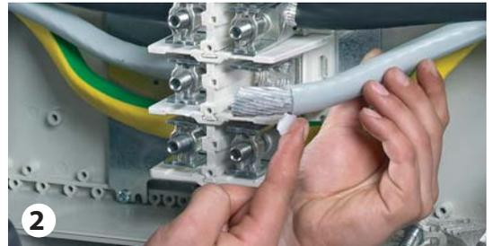
Сразу же после снятия окисла контакт нужно покрыть консистентной смазкой, не содержащей кислоты и щелочи, например, техническим вазелином, и незамедлительно подключить к клемме. Это, в свою очередь, предотвратит образование непроводящего ток слоя окисла.
