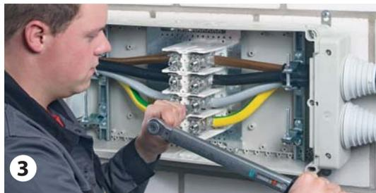
Из-за текучести алюминия клеммы нужно затянуть перед пуском и после первых **200 часов работы** (в соответствии с требуемым затяжным моментом).
