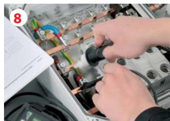
Корпуса распределительного оборудования на токи до 250 А, эксплуатируемые неквалифицированным персоналом, проверяются напряжением 500 В пост. тока. Все корпуса на токи свыше 250 А проходят тест на выдерживаемое напряжение промышленной частоты.
