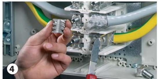
Перечисленные действия нужно повторять после каждого отключения и повторного подключения провода. Это означает, что его снова нужно зачистить, смазать и сразу подключить.
