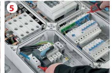
Необходимо проверить соответствие проводов однолинейной схеме. В произвольном порядке проверить болтовые соединения.
