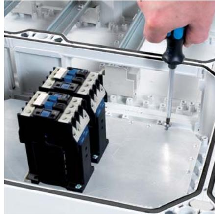
Прикрепите DIN-рейку прямо к основанию корпуса или на держатель DIN-рейки FP DS 02 на высоте 29,5 мм (53,5 мм).
