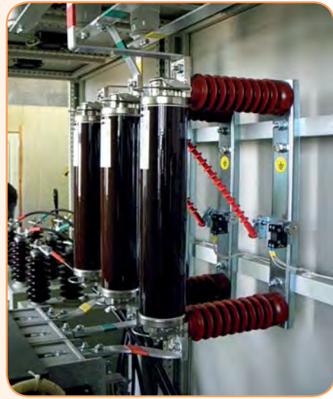
Установка внутренних держателей предохранителей*
