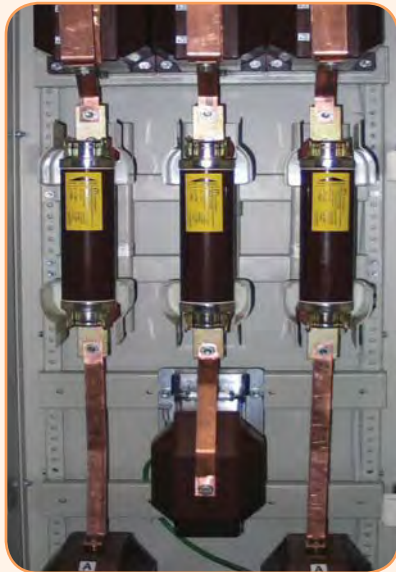
Внутренняя установка предохранителей
